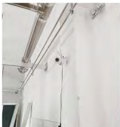
施工现场安装图片
