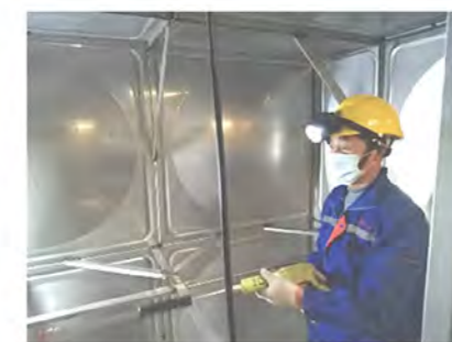
整改后施工现场
