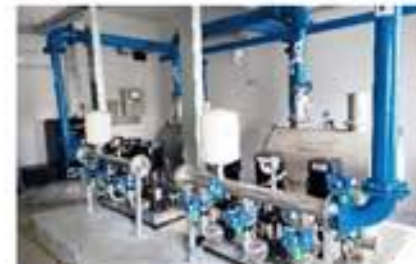
新建二次供水泵站
