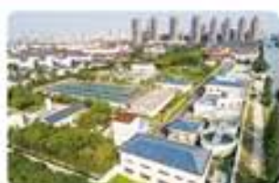
第二自来水厂 深度处理改造
