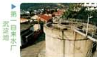
第一自来水厂 沉淀池
