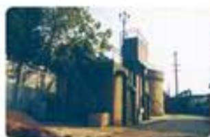
第一自来水厂 滤池
